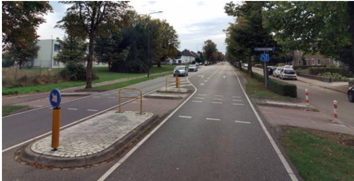
Figuur 2-9 Fiets- en voetgangersoversteekplaats ter hoogte van de Heijersteeg
