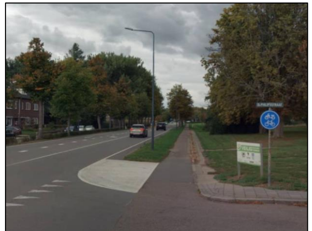
Figuur 2-4 Eenzijdig fietspad langs de Rijksweg Noord
